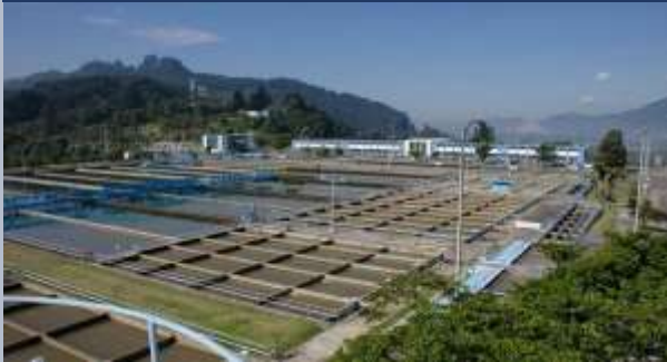
Acueducto en Bogotá
